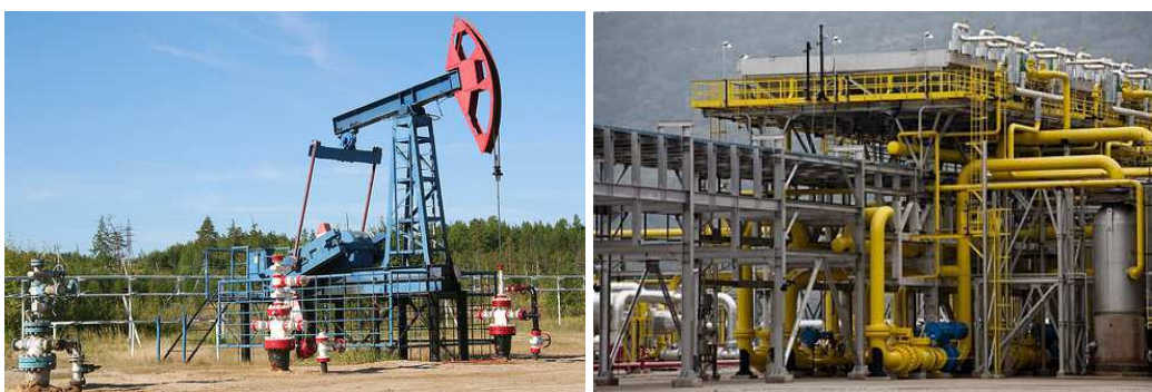
Figura 2: Equipamentos existentes na extração e produção de petróleo em campo terrestre.
